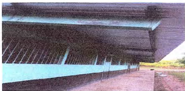
Estructura del entechado de la escuela
