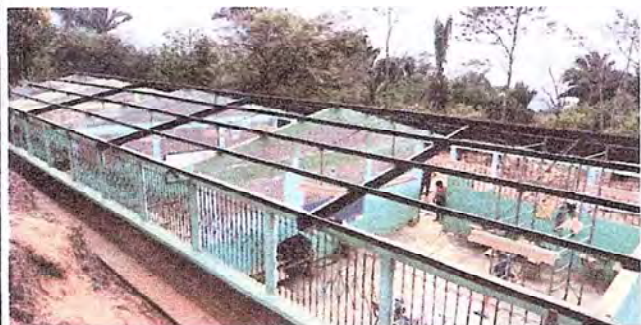
Foto1: proceso de sustitucion del soporte metalico.
