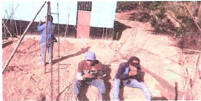
Foto 2: proceso de construcción
