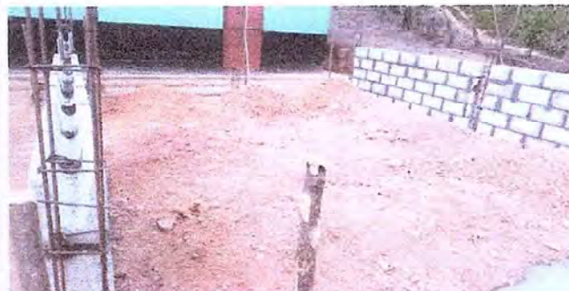
Proceso de levantamiento de muro
